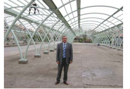
Salı Pazarı Çatı Kaplama
