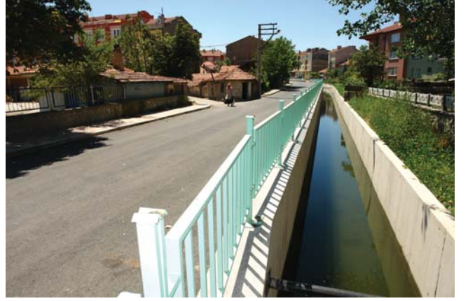
Dere Islahı ve Yol Geniştirme Çalışmaları
